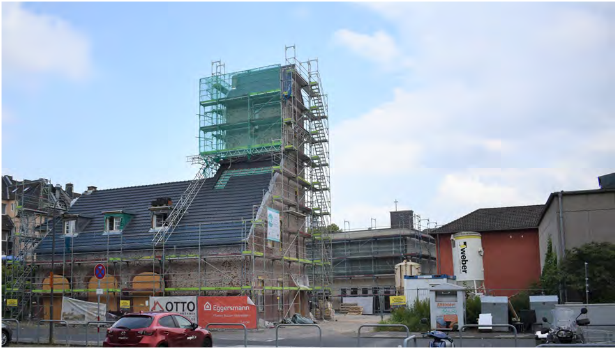
Der Quartierstreffpunkt während des Umbaus (Quelle: Stadt Leverkusen)
